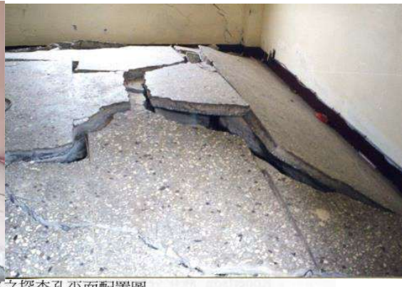
圖 5-8 太平市光復路之樑本瓦面斷裂圖
