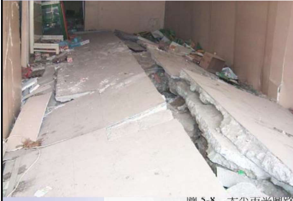
圖 5-8 太平市光復路之樑本瓦面斷裂圖
